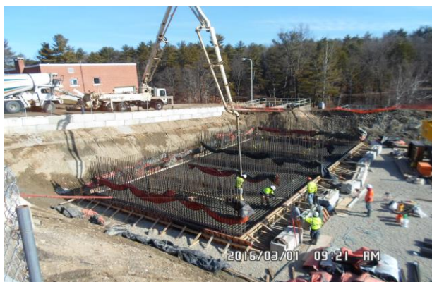
Aeration Basin Concrete Pour
